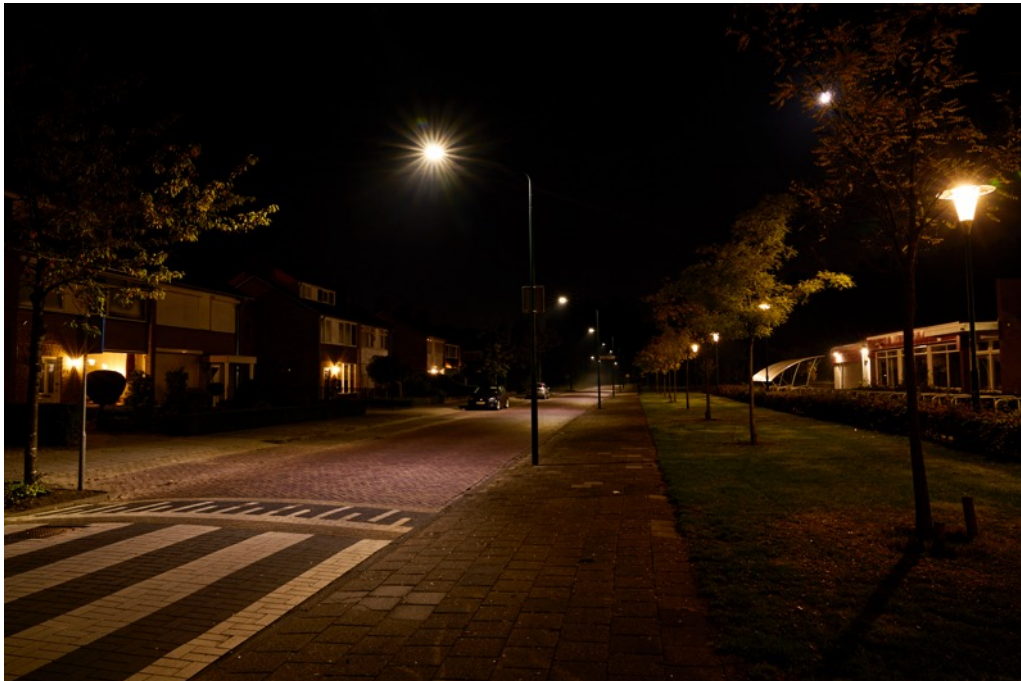
Foto: Beek en Donk Otterweg, nieuwe verlichting die gericht is op de weg en niet rondom schijnt.
